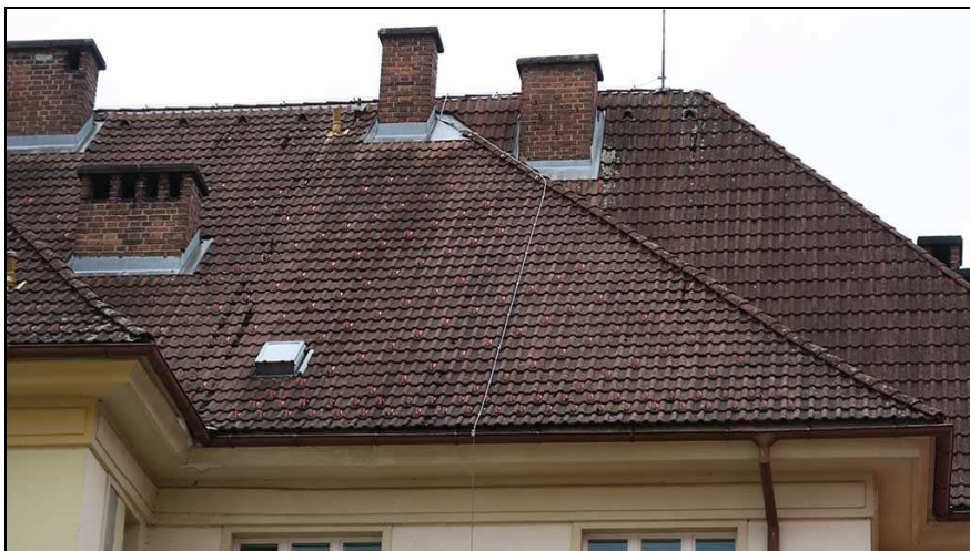
Střechu jižního křídla kryjí betonové tašky.
