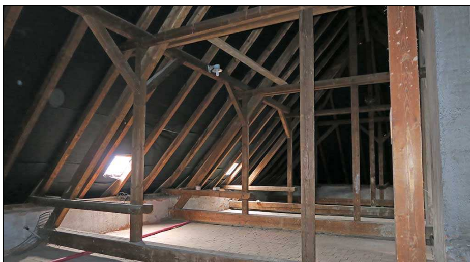
Půda severního křídla s polopropustnými zajišťovacími foliemi pod krytinou.
